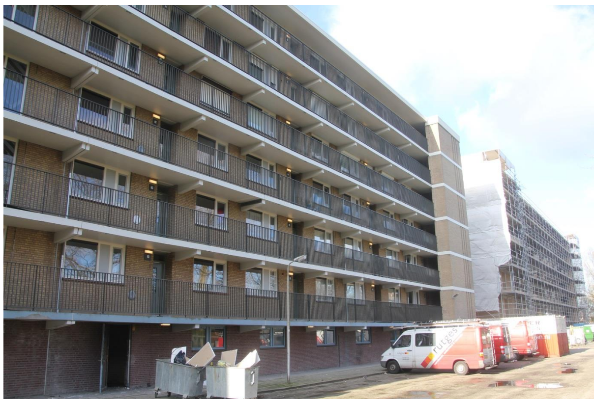
Figuur 1 Complex Ariaweg, Amersfoort
