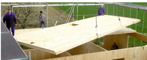
Houten vlakke plaatvloer
