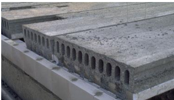
Geïsoleerde kanaalplaatvloer
