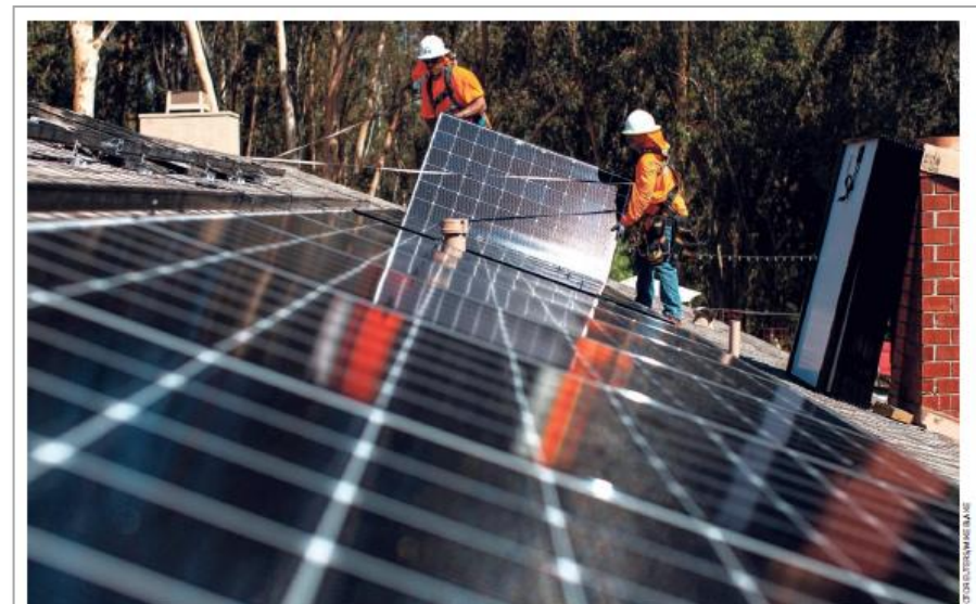
Installatie van zonnecellen op het dak van een huis in San Diego, Californië, eerder deze maand.
